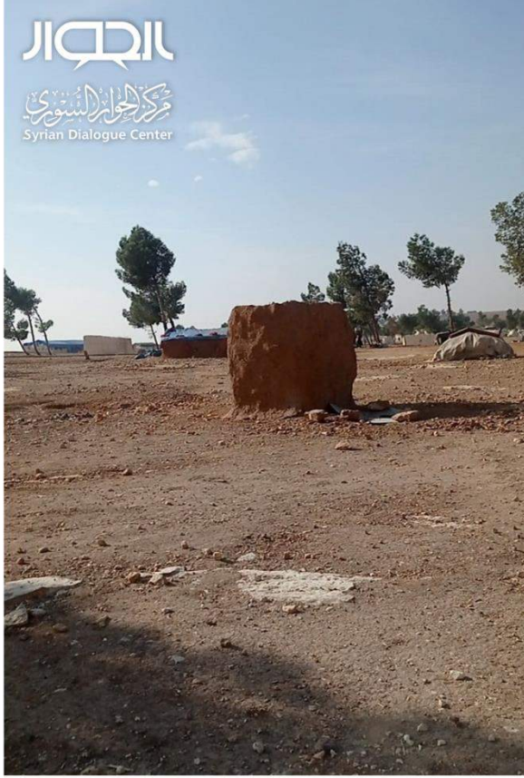
مرحاض في مخيم عشوائي عبارة عن حفرة في الأرض يحيط بها 3 جدران طينية بارتفاع 1 متر دون وجود أي سائر (صورة خاصة)
